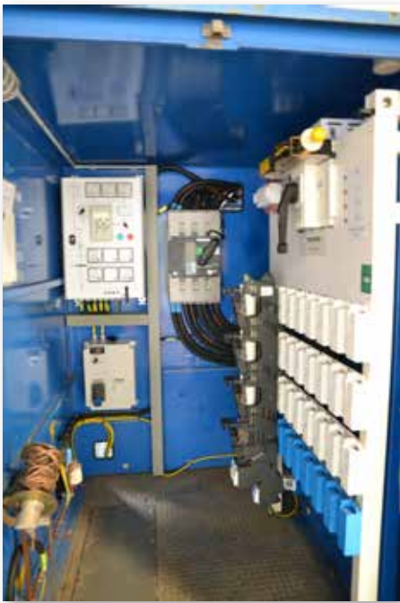
TGBT mis à niveau avec TIPI-8
